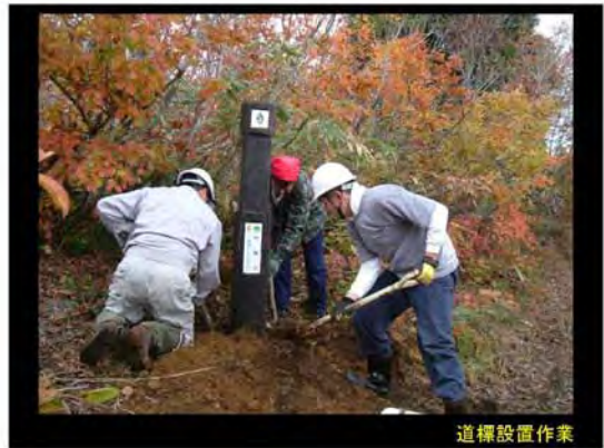
道標設置作業
