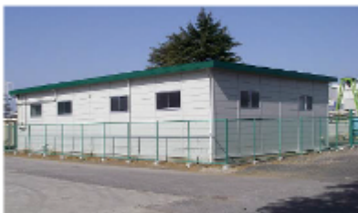
メリーズシステム資源循環 センター
