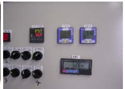
写真9 遠隔監視制御盤
