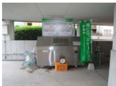
オ. 生ごみ処理機の設置
