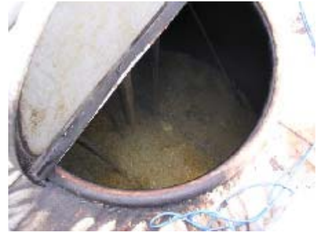
写真6 発酵槽（タンク）内部
