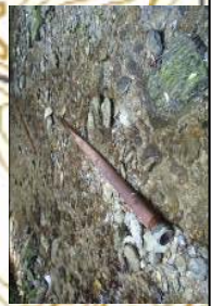
使われていない水道管；撤去が望ましい
