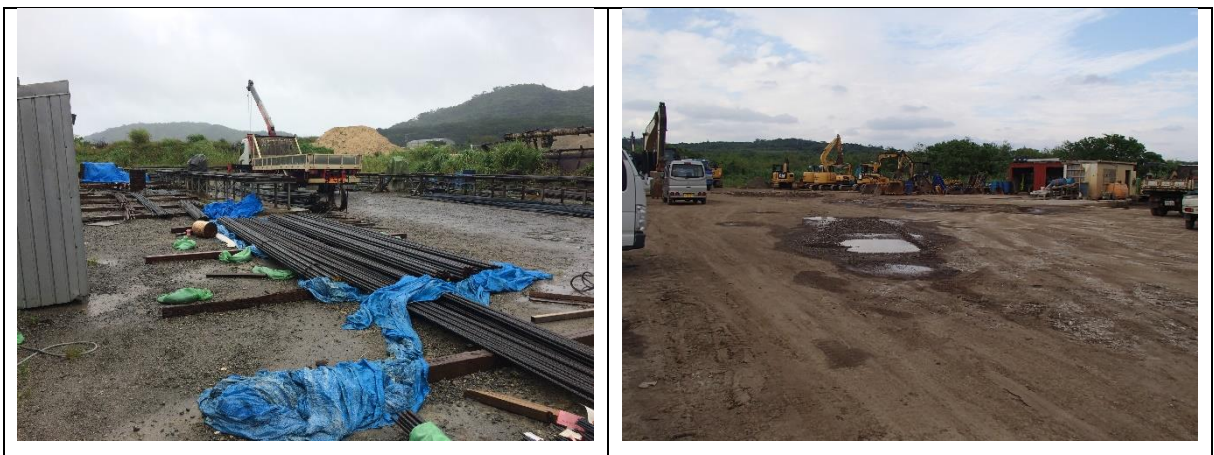
図 2.4 選定した資機材置き場（左：資機材01、右：資機材02）
