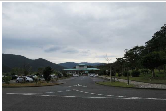
写真② 駐車場入口付近から見たマングローブ館
