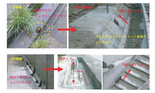
図22. 片側勾配側溝及び桝タイプ側溝への改良。いずれも動物が森林側へ脱出できるよう改良されており、 実際にリュウキュウヤマガメやシリケンイモリが勾配を這い上がる様子が確認されている(沖縄県北部土 木事務所維持管理班、2010)。
