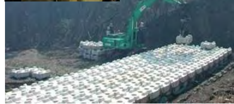
ブロック積み作業（三宅島）
