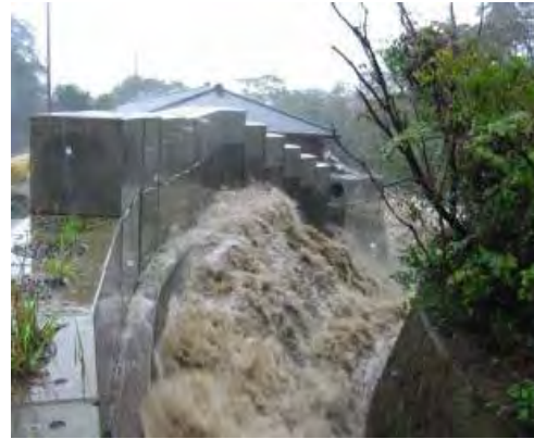
コンクリートブロックにより嵩上げされた流路工を流れる泥流（三宅島）
