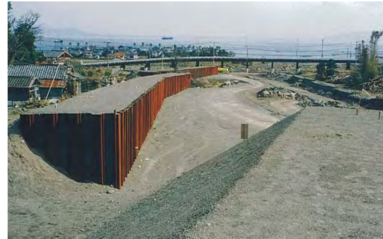
仮設導流堤の施工（雲仙・普賢岳）
