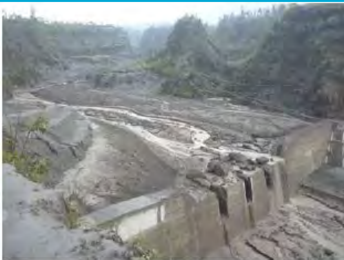
図 2.1.7 砂防施設の効果 (Apu 川 AP-RD1a) (2011 年 1 月撮影)
