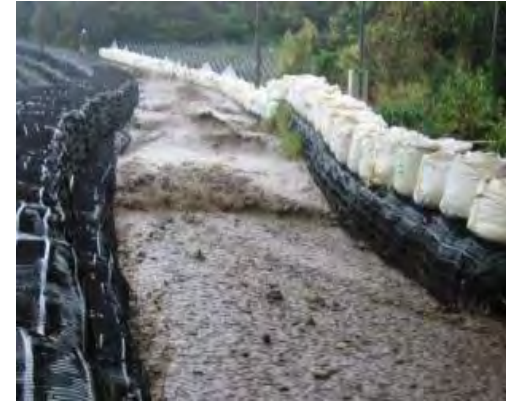
大型土嚢で施工された仮導流堤を流れる泥流（三宅島）
