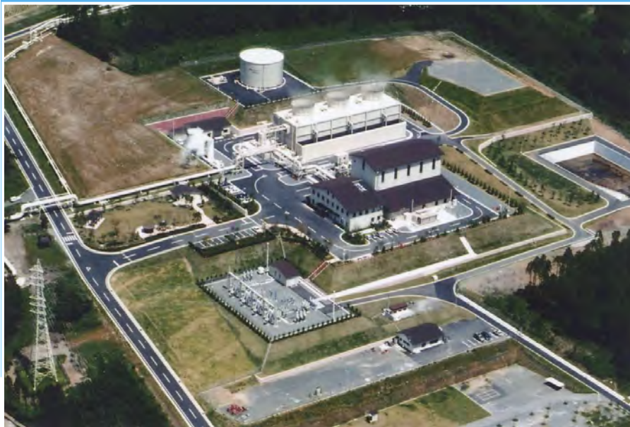
大霧地熱発電所（九州電力(株)）
