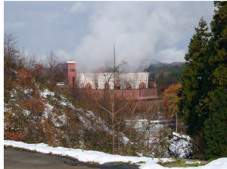
柳津西山地熱発電所 (出典:環境省)
