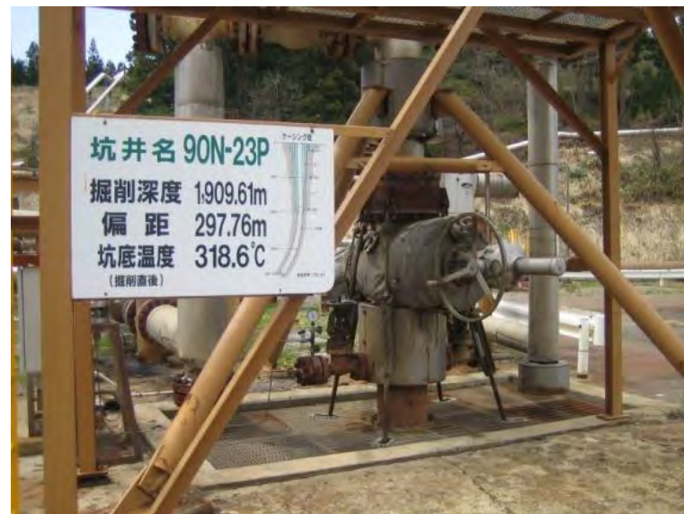
柳津西山地熱発電所(出典:環境省)
