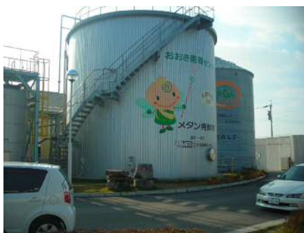
メタン発酵槽
