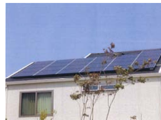
住宅用太陽光発電システム
