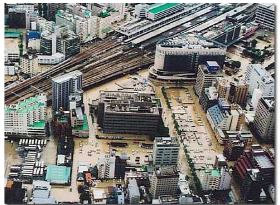
■2003年7月19日の九州集中豪雨（博多駅周辺）
