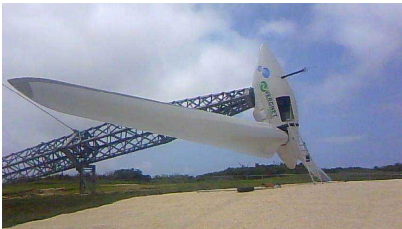
■可倒式風力発電機（波照間島）
