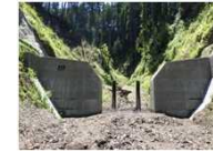
流木捕捉式治山ダム
