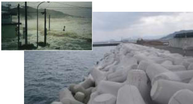
新門司地区における護岸整備状況
