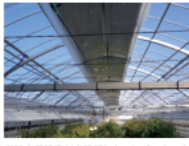
高効率保温資材を設置したマンゴーのハウス。資材が放射冷却現象を防ぎ、断熱効果を発揮します。
