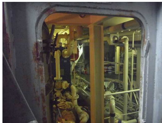
<機関室の開口部>
