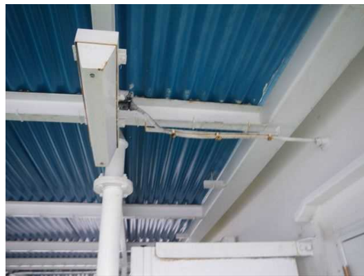
<デッキ構造物の隙間等>
