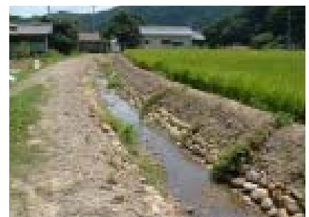
現地発生材を使った石積排水路（出典：ながさき農業農村整備推進計画 2011-2015）
